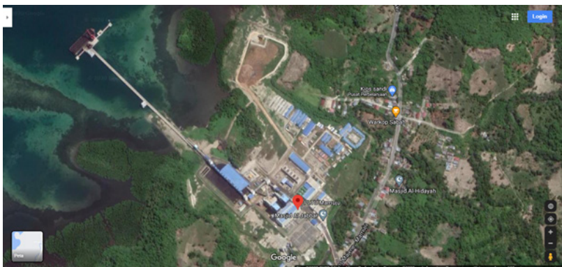
Gambar 24. Tampak atas PLTU Mamuju di Google Maps
